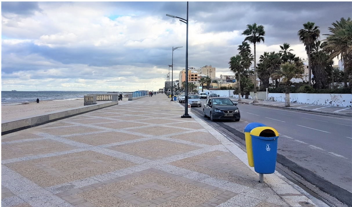
Figure 63 : La Corniche Photo : Kandeel, 2020
