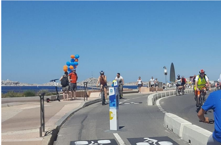
Source : Nouvelle piste cyclable sur la corniche de Marseille
