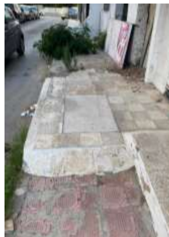
Ruptures au niveau des traitements des trottoirs
