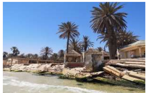
Vestiges d'un hôtel à l'abandon entravant le passage
