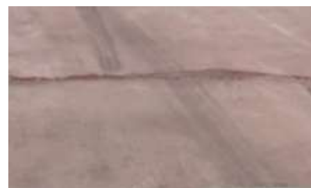
Béton stabilisé teinté dans la masse
