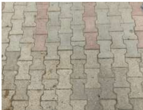
Pavé autobloquant posé sur lit de sable
