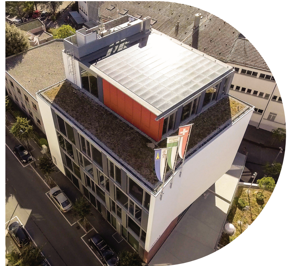
La nouvelle Maison de Quartier à Clarens est labellisée Minergie ECO
