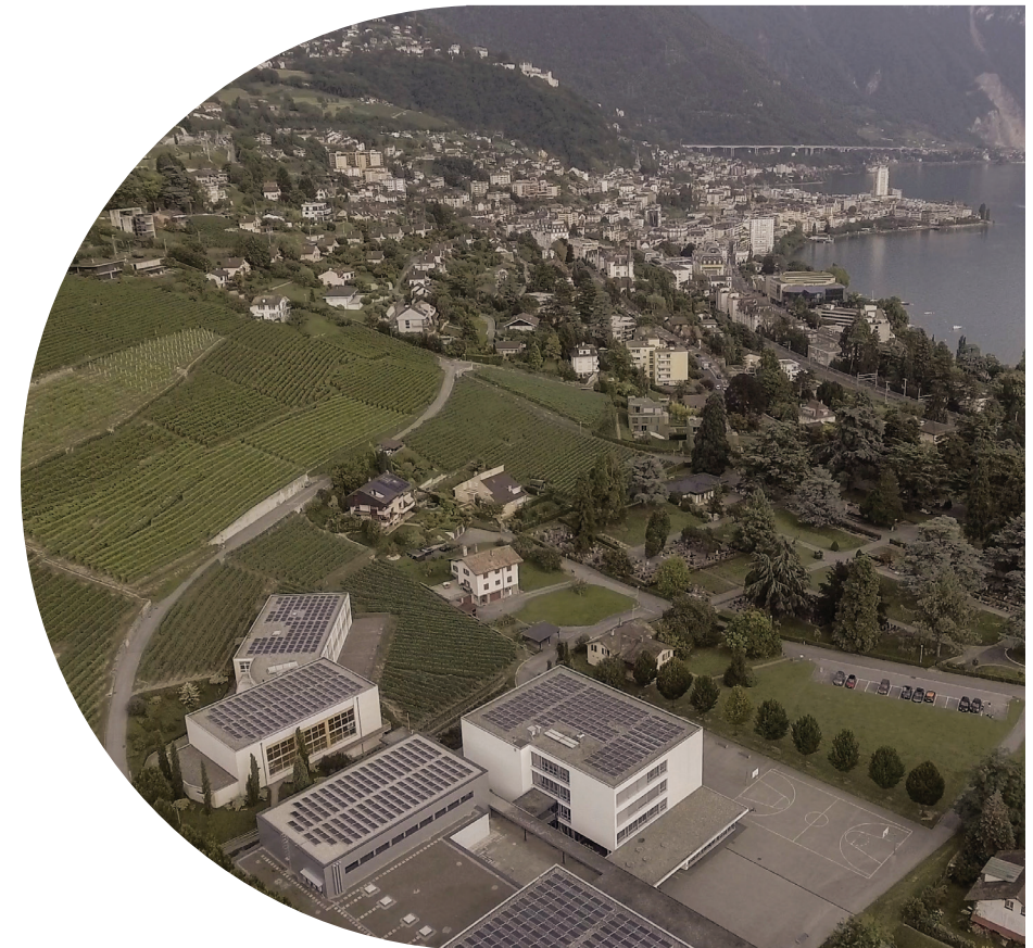
Installation photovoltaïque du collège Rambert
