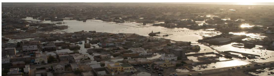
Vers Cité Concorde, commune de Sebkhâ : en 2013, des inondations spectaculaires ont touché la ville de Nouakchott.
