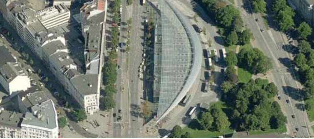
Un pôle d'échange à Hambourg.
