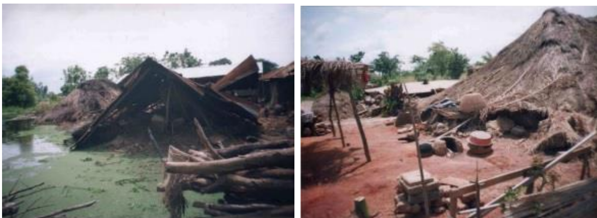
Photo 2: Destruction de maisons à Kpoto - Zagnanado
